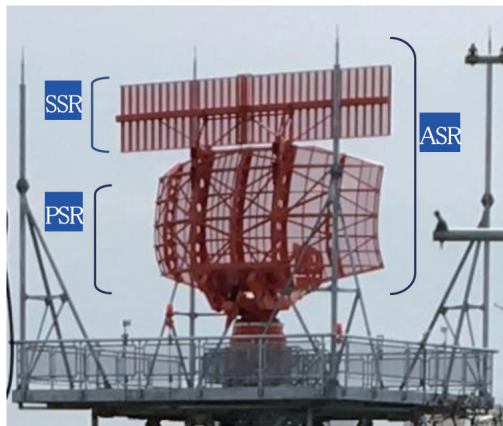
図1 空港監視レーダ(ASR)の例
